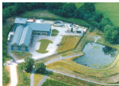
Przykład zdalnej przepompowni
